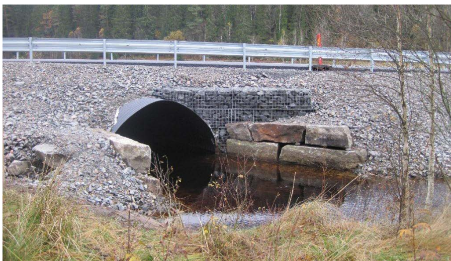
EXEMPEL: Andra sidan på trumman är rakt skuren och här har man lagt huggen sten och gabioner för att få en mindre släntbredd. Kan vara ett alternativ för den nya trumman då det blir trångt mot byggvägen.
